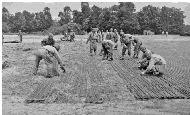
7. ábra A le- és felszállópálya építése 17
