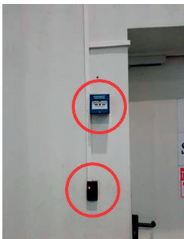
3. kép. Érintőkártyával nyitható mágnessel rögzített ajtó vésznyitó nyomógombbal (Saját felvétel)
