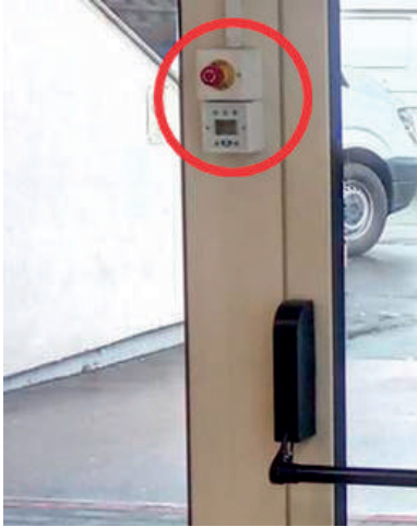
5. kép. Elektromos motorral rögzített vészkijárat pánikrúddal és vésznyitó nyomógombbal (Saját felvétel)
