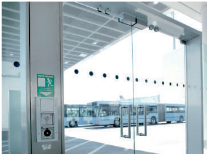
13. kép. Nyomógombbal nyitható vészkijárat MSZ EN 13637 szerinti kialakítással [30]
