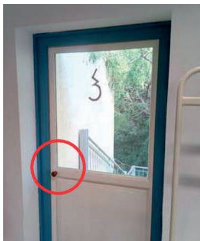
4. kép. Mágnessel rögzített vészkijárat fogantyúval, nyitó gomb nélkül, tűzjelzésre nyílik (Saját felvétel)
