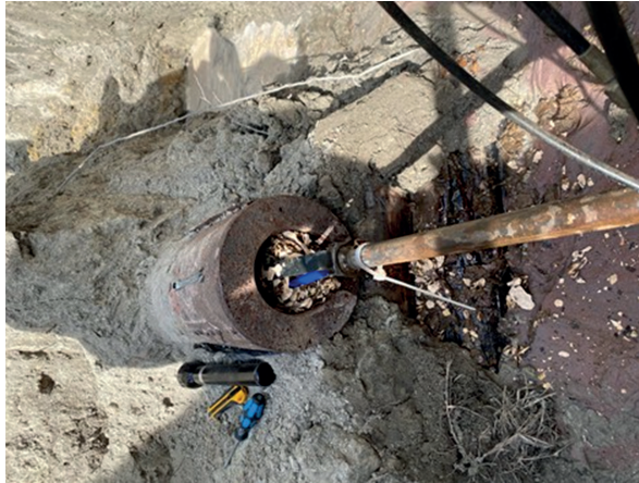
5. ábra A vágás során keletkező tömedék
