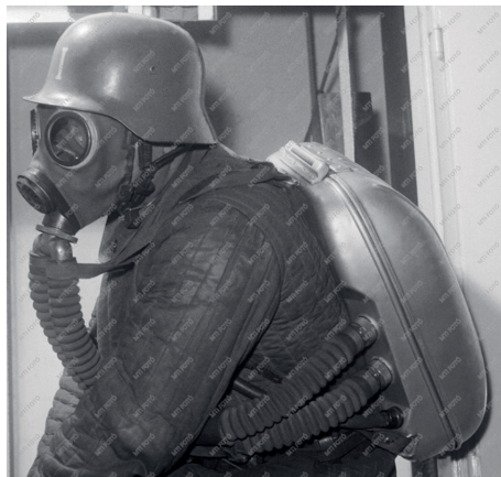
5. ábra: I. kerületi tűzoltó, Dräger KG120-as típusú újralégzővel. A légző képes volt a 34M álarc fogadására, a kilégző-szelep lezárása és a belégzőszelep eltávolítása mellett
