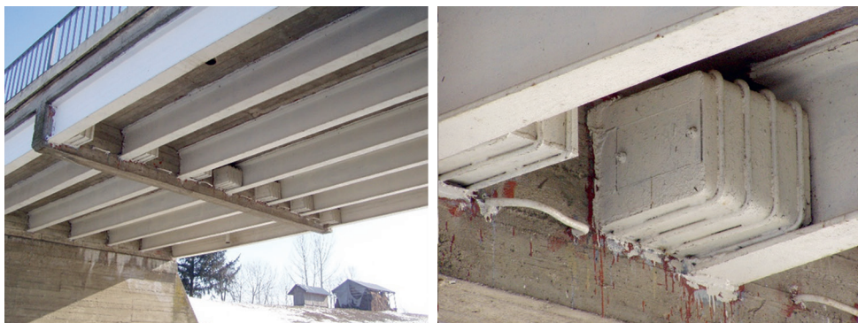
6. kép: Tiszaberceli Lónyay-főcsatorna-híd robbantószerelvényei
