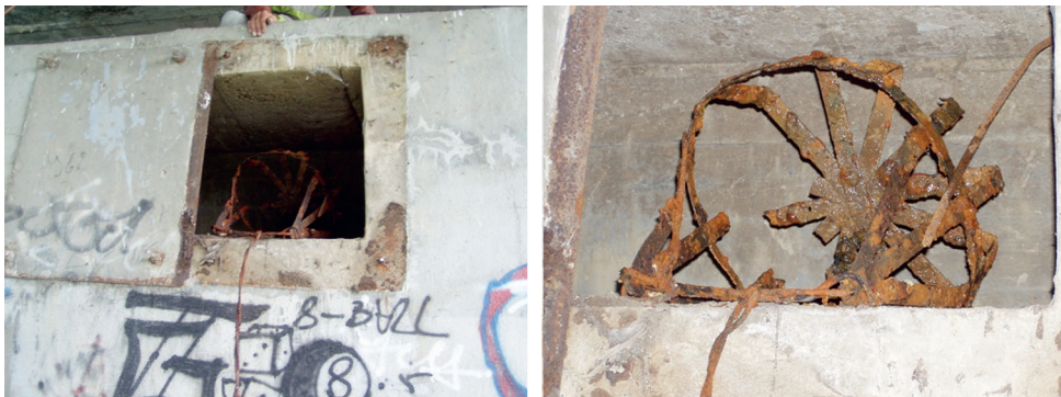
5. kép: A tiszalöki Keleti-főcsatorna-híd kibetonozott robbantóaknája a leeresztő kosárral Forrás: a szerző felvétele
