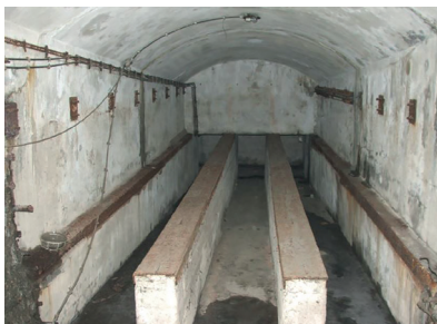
21. ábra. Részben elbontott olajos kavics-nyomáscsökkentő és -szűrő váza a KAGRA-létesítményben
