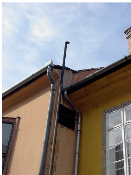
32. ábra. Lavallcső kipufogóvezeték a Sziklakórháznál a budai Várban lévő Uri utca egyik ház homlokzata mellett
