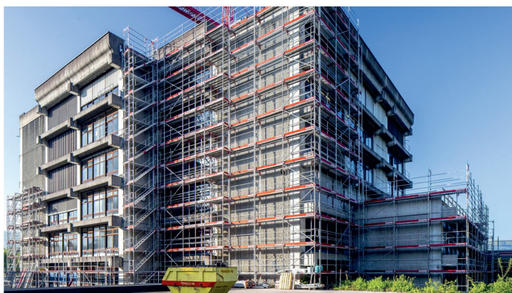
3. kép: Példa a keretes homlokzati állványra: iskola felújítása a svájci Oltnban Forrás: In 60 Jahren vom Kleinbetrieb zur «Nummer Eins» [é. n.]
