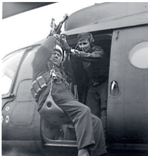
7. ábra: Emberek mentésére alkalmazott heveder próbája
