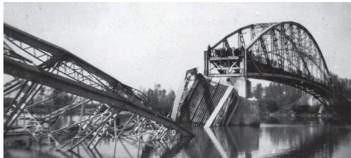
7. ábra: A félig rombolt drávaszabolcsi közúti híd
