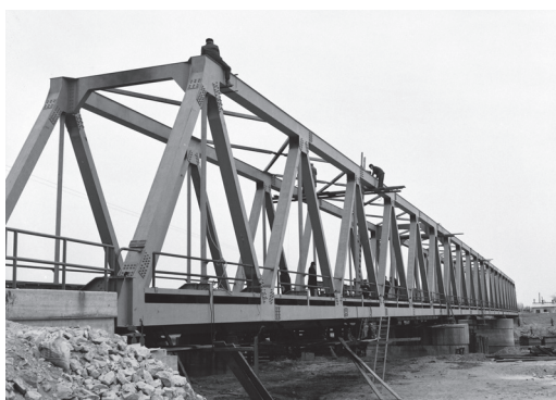
17. ábra: A murakeresztúri híd újjáépítése 1975-ben
