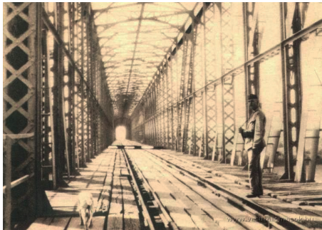
10. ábra: A barcsi vasúti híd Forrás: www.vasutallomasok.hu/allomas.php?az=barc
