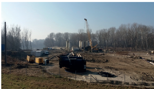
5. ábra. A Tassi többfunkciójú vízleeresztő műtárgy kivitelezése
