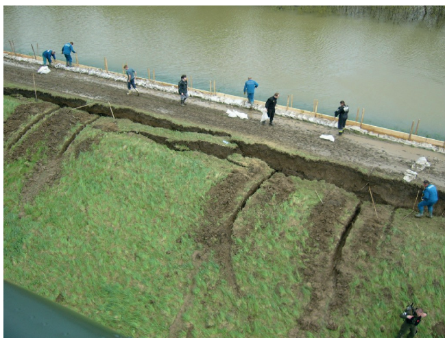
1. ábra. Töltéscsúszás a Hármaskörös jobb part 0 + 500 tkm szelvényben
