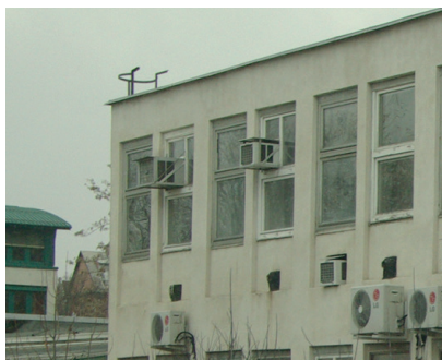
7. ábra. Nyílászáróba épített és falra szerelt klímaberendezések
