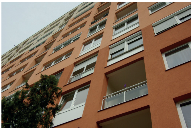
6. ábra. Utólagos lodzsabeépítések egy energetikai korszerűsítésen átesett panelos épületen
