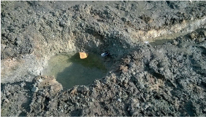
3. ábra. Gyűjtőzsomp kialakítása
