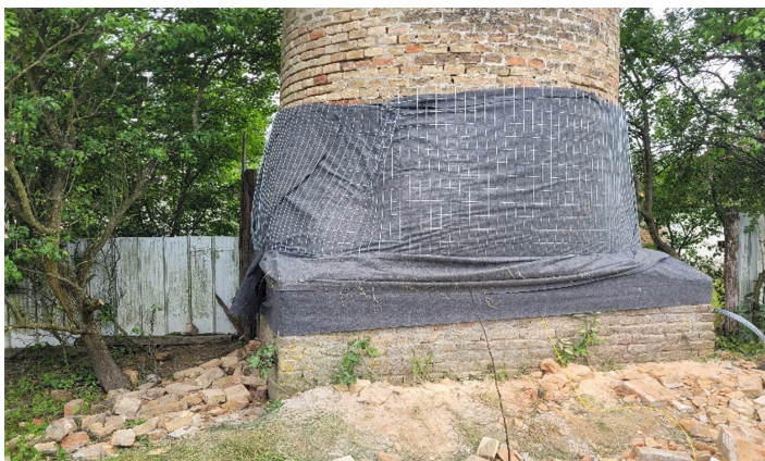
6. ábra: A megépített repeszvédelem
