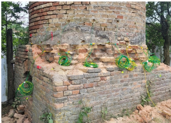
5. ábra: A betöltött, hálózatra kötött lyukak
