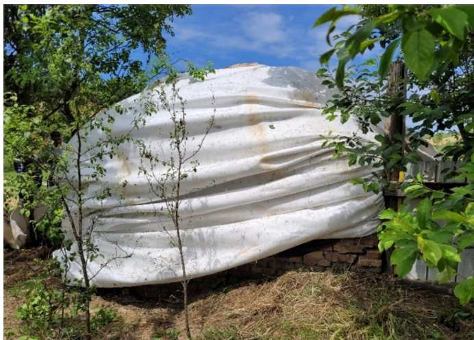
8. ábra: Repeszvédelem a robbantási sávval ellentétes oldalon
