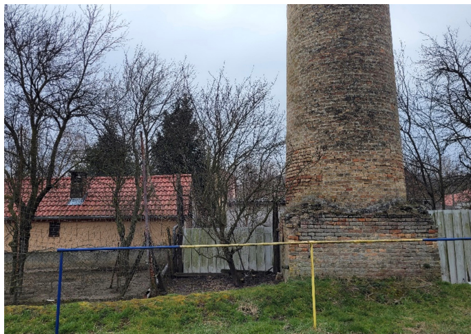
1. ábra: A kémény közvetlen környezete
