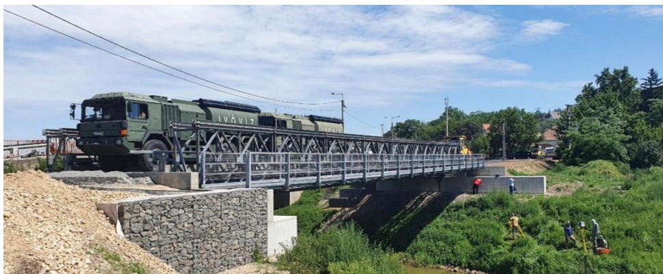
2. ábra: A pincehelyi Kapos-híd átépítéséhez használt katonai provizórium
