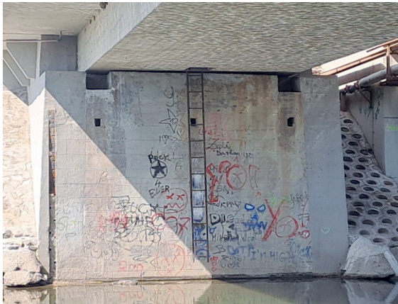
4. kép: A mezőtúri Hortobágy–Berettyó-csatorna-híd kéményajtós robbantófészkei napjainkban (a két felső, nagyobb fészek a híd emelési pontjai, a három kisebb nyílás a robbantónyílás) Forrás: a szerző felvétele
