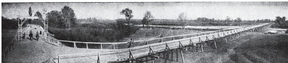
2. ábra: A műszakiak által, mocsaras területen épített híd
