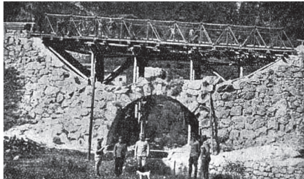
5. ábra: A rombolt kőhíd megerősítése Herbert-hídmezővel
