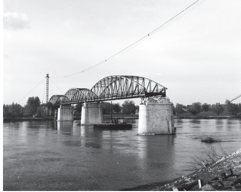
11. ábra: A megrongált közúti híd Barcsnál
