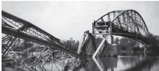
7. ábra: A félig rombolt drávaszabolcsi közúti híd
