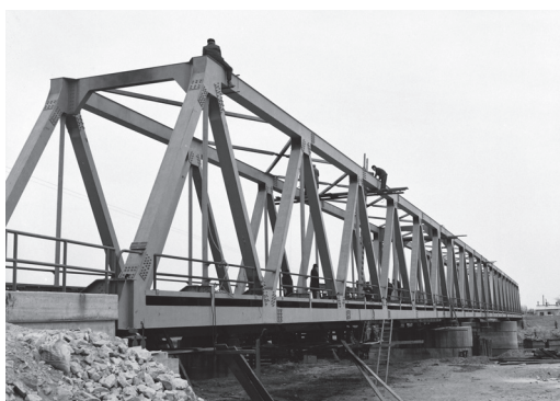
17. ábra: A murakeresztúri híd újjáépítése 1975-ben
