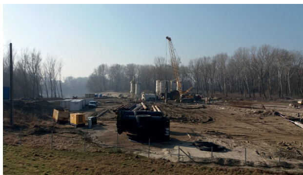
5. ábra. A Tassi többfunkciójú vízleeresztő műtárgy kivitelezése
