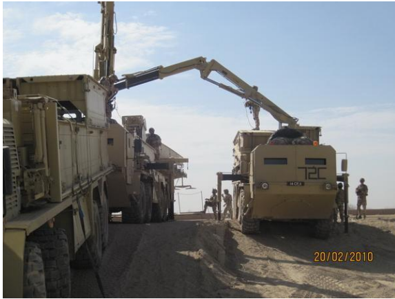
9. sz. kép A híd építése 22
