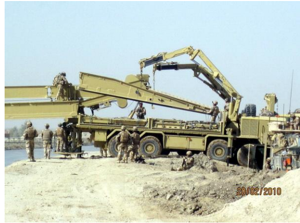
10. sz. kép A feljáró elem beépítése 23
