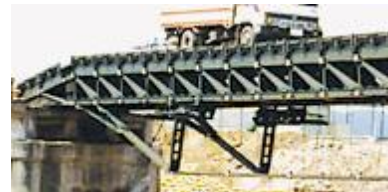
5. sz. kép Megerősített kettős tartószerkezetű híd
