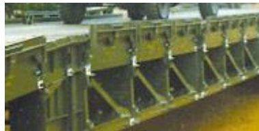
4. sz. kép Kettős tartószerkezetű híd
