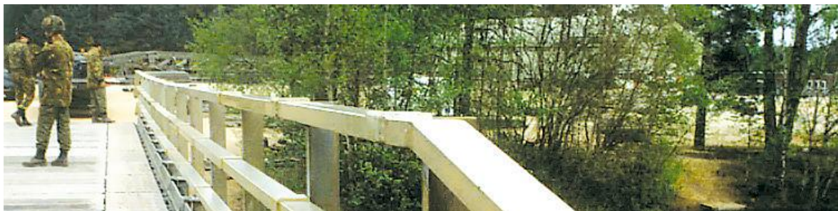
15. sz. kép A kész híd szegéllyel és korláttal 26
