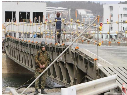
2. sz. kép A japán földrengés és cunami után épült híd 2011. március 7
