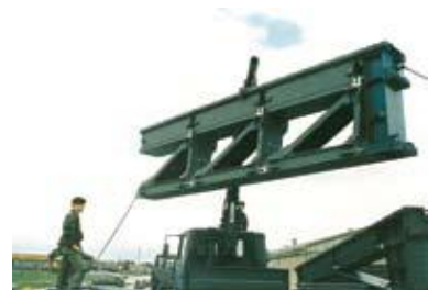
14. sz. kép A kész elem beemelése 25
