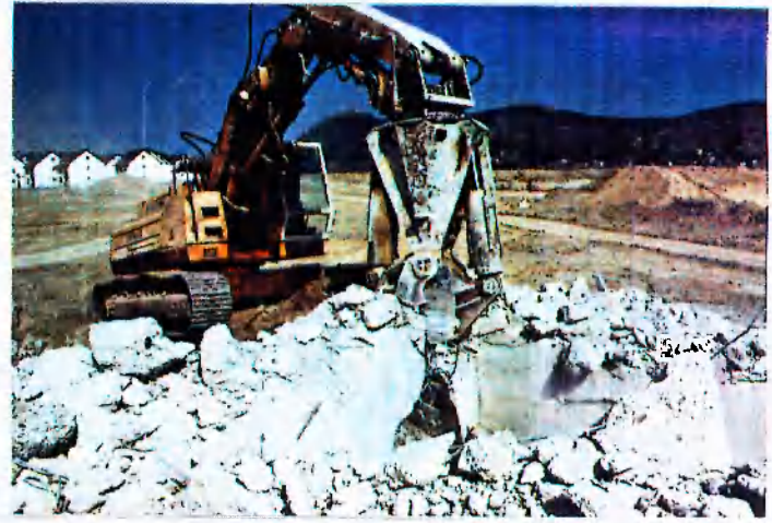
Visegrád-Nagymarosi tájrehabilitáció során elbontott vasbeton szerkezetek.
