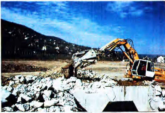
Visegrád-Nagymarosi tájrehabilitáció során elbontott vasbeton szerkezetek.
