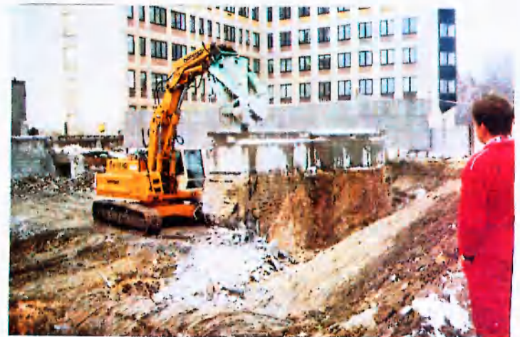
Visegrád-Nagymarosi tájrehabilitáció során elbontott vasbeton szerkezetek.
