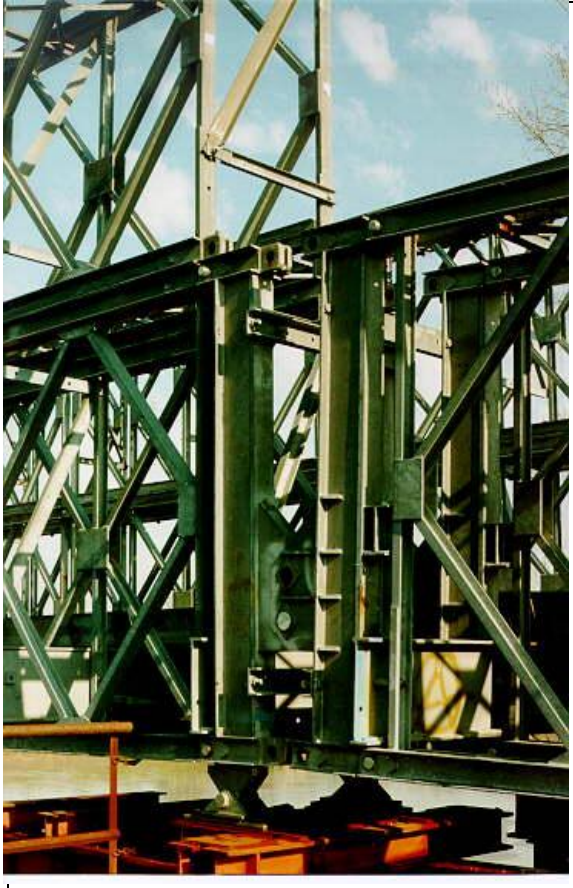
5. ábra: Feszített szerkezet az összezárási előtt
