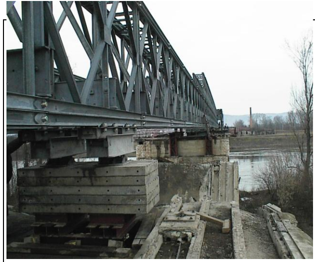
6. ábra: Máglyákra és görgőkre helyezett hídszerkezet
