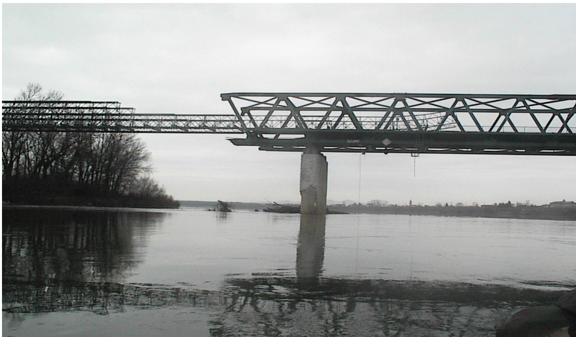
7. ábra: Hídszerkezet kihúzás közben, az orr-résszel
