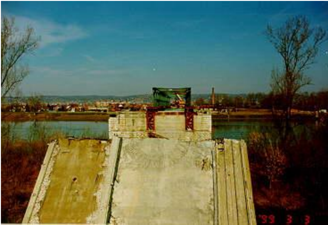
9. ábra: Bontás után a lerombolt híd maradványai
