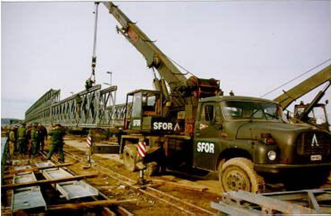
8. ábra: A hídszerkezet szétszerelése
