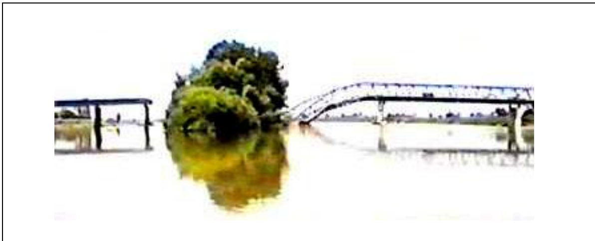
1. ábra Lerobbantott híd a felderítés időszakában
