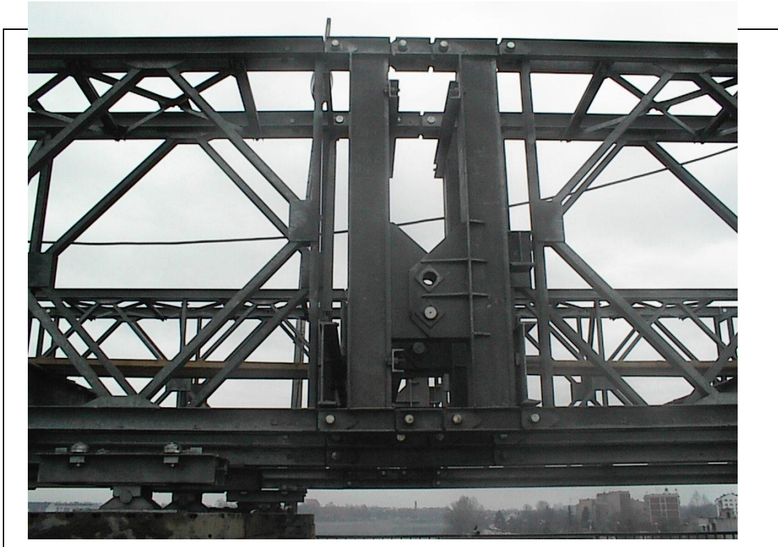
4.ábra: Feszített szerkezet összezárás után
