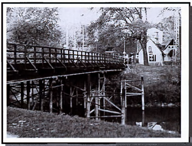
1. ábra: A papszigeti híd
