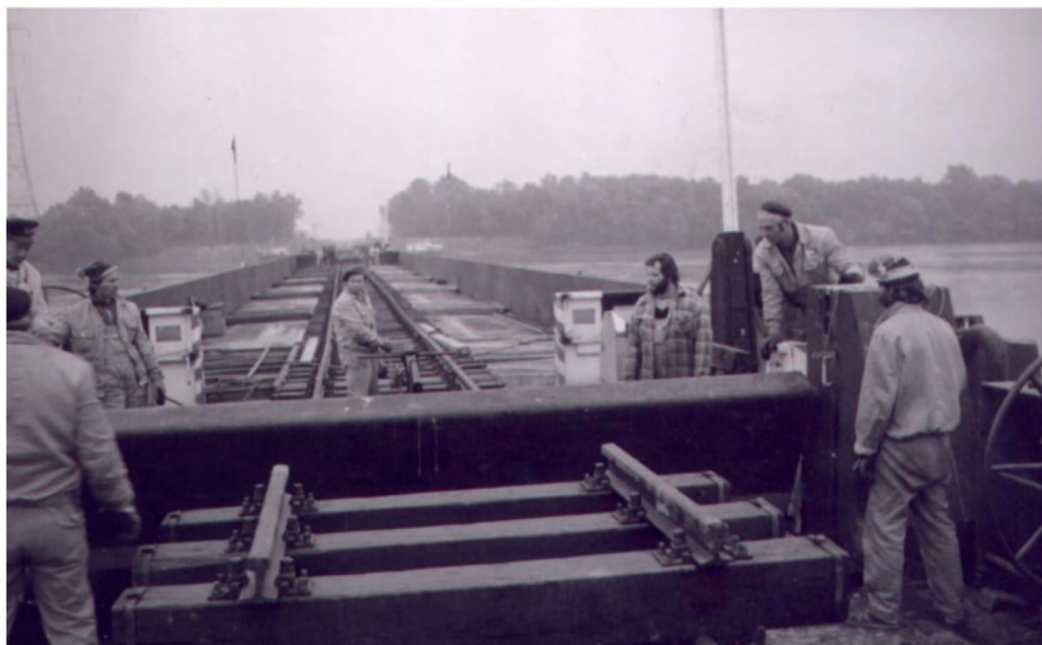
A vasúti pályaszerkezet építése az uszályhídon
