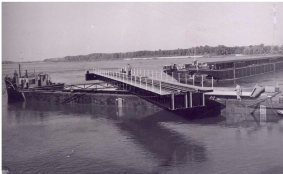
A vasúti feljáráshíd beépítése
