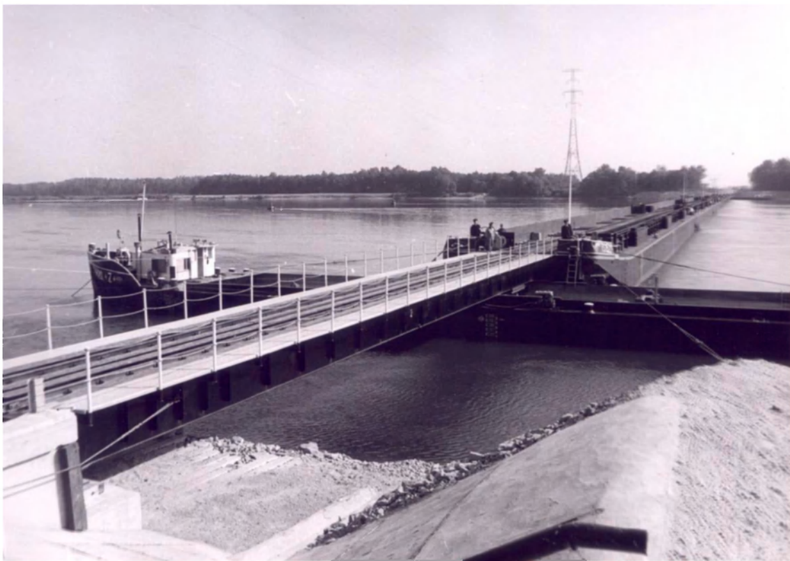
A már beépített vasúti feljáróhíd és az elkészült uszályhíd
