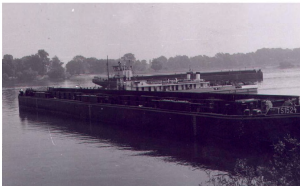
A TS-uszályhíd építése I.
