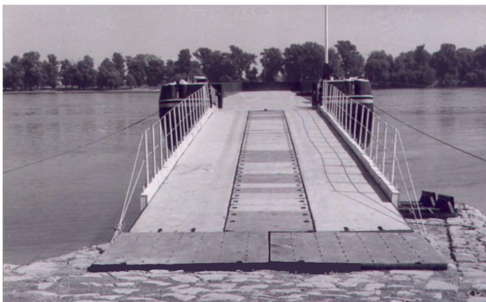
A közúti hídfeljáró, amelyen jól láthatóak a 2 db felhajtást megkönnyítő éktest (elötérben) és a teherbíró tálcák (középen)
