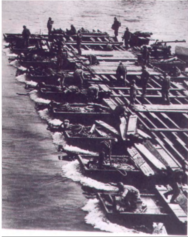
szovjet pontonhíd építése
