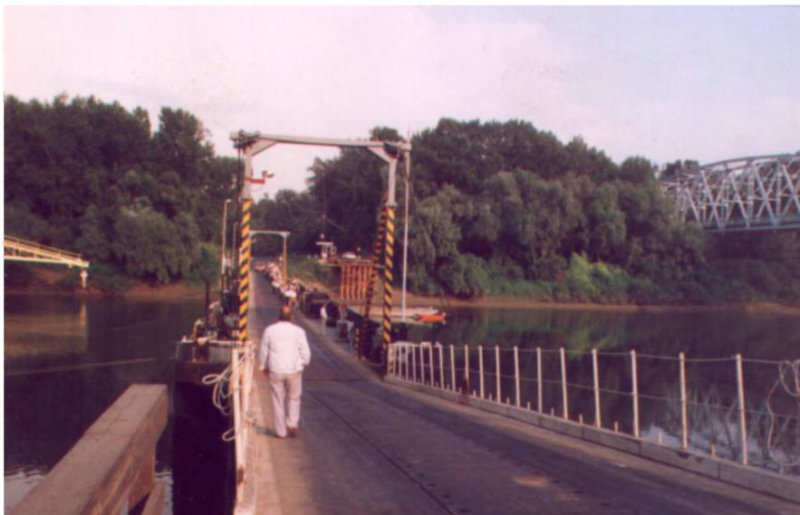
A tokaji Tisza-híd pótlására épített uszályhíd II
