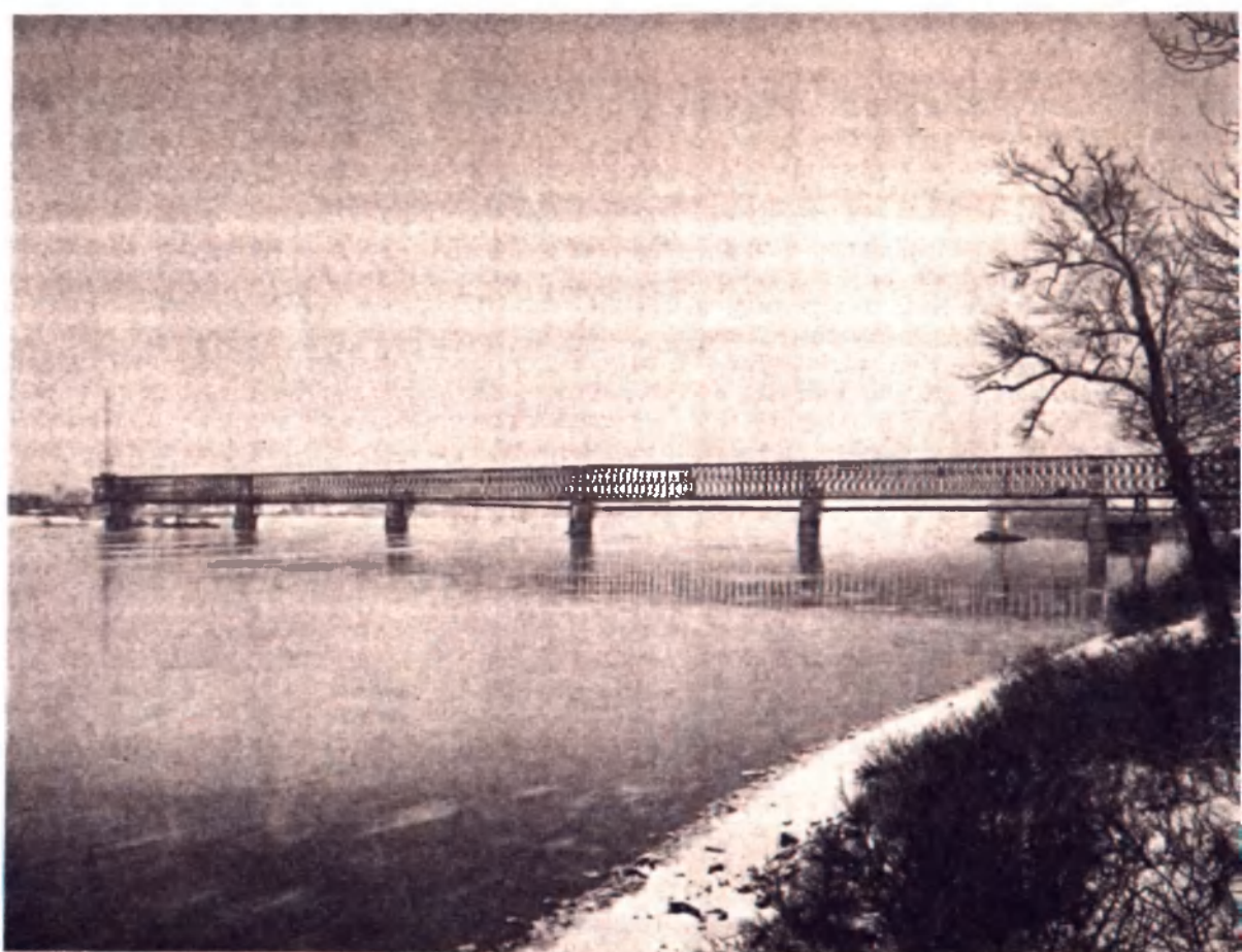
Az Újpesti Vasúti Híd 1955- ben elkészült “ K ” rendszerű csavarkötéses vasszerkezete 5. áb
