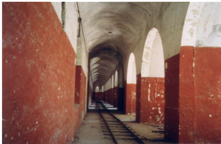
Tüzérbástya védőfolyosója a lőszerszállító kisvasúttal
