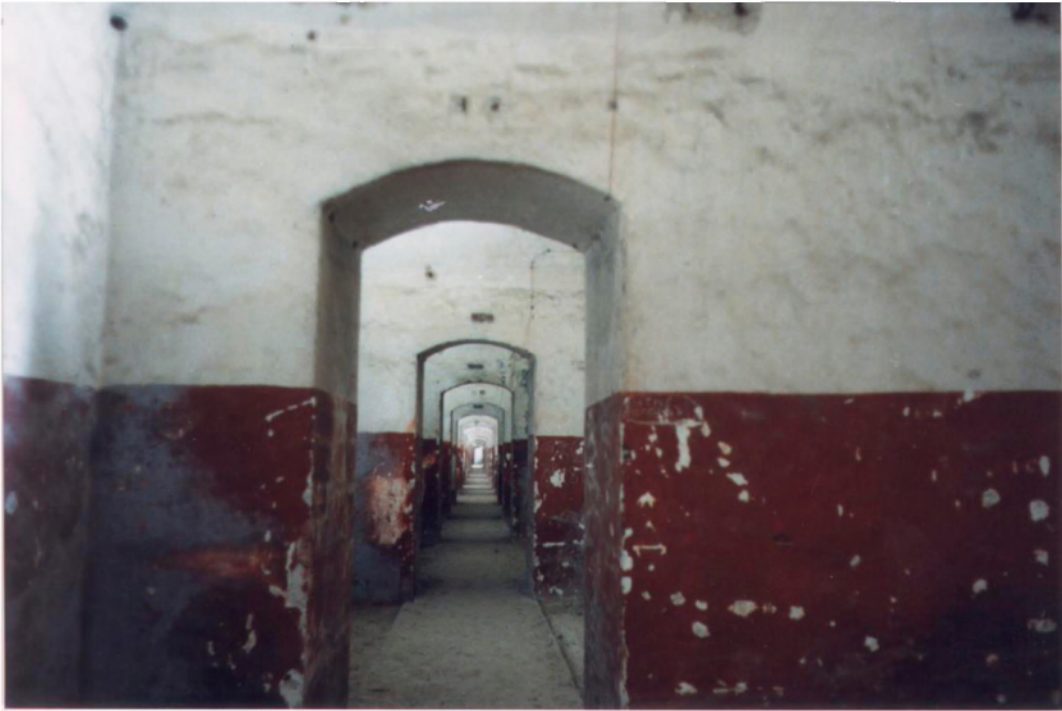
A kazamatasor északi szakasza
