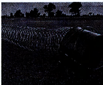
11.sz. ábra Harcjármű elleni dróthenger telepítése
