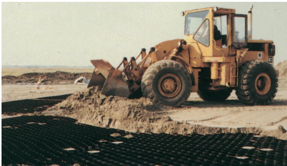
12. ábra: Geocellák beépítése
