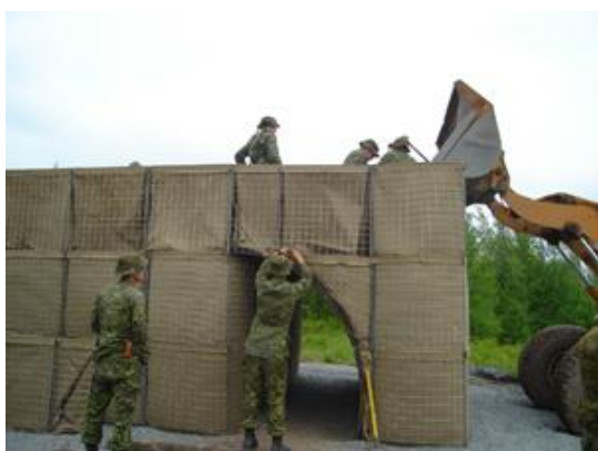
Az elkészült RAM típusú óvóhely 29
