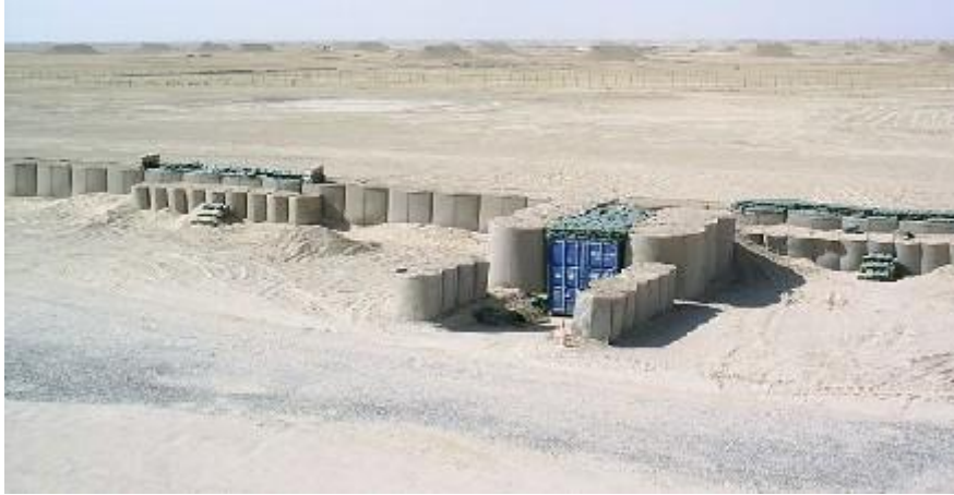
Anyagok tárolására berendezett konténer óvóhely 27
