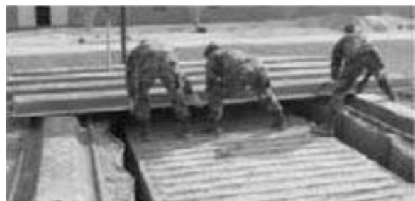
Fokozott védelemmel rendelkező óvóhely földemének beépítése 32
