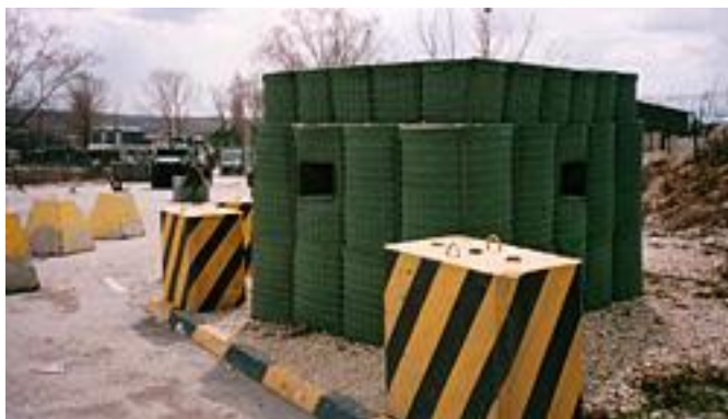
Az őrhely/figyelőpont kialakítása 37
