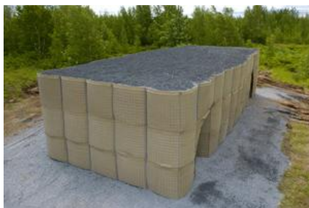
Az elkészült RAM típusú óvóhely 29
