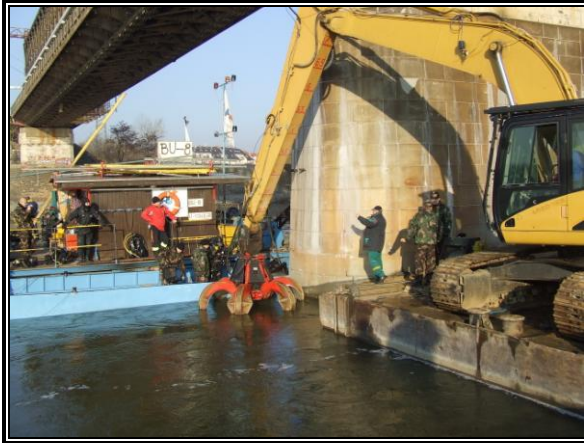
6. ábra: Kotrógép a hídpillér mellett 7
