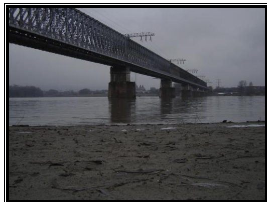
2. ábra: A köznyelvben sokszor Északi összekötő vasúti híd 3
