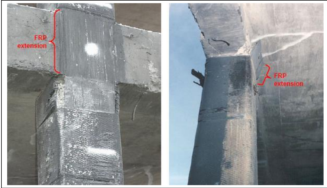
3. ábra: Erősítőcsíkok túlnyújtása
