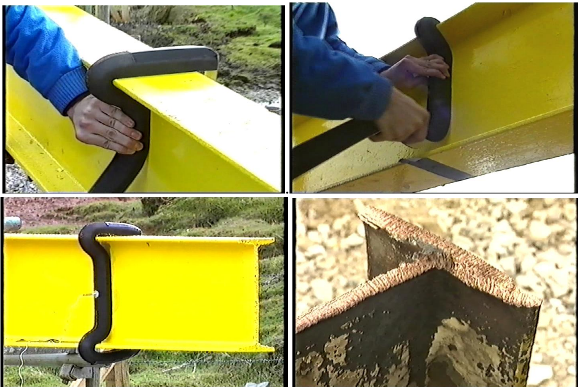
17. számú ábra: BLADE lineáris vágótöltettel szerelt acéltartó robbantása 44
