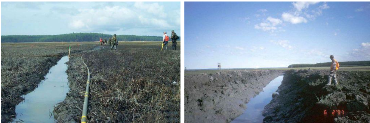
2. sz. ábra Csatorna szélesítése, mélyítése tömlős töltettel 5
