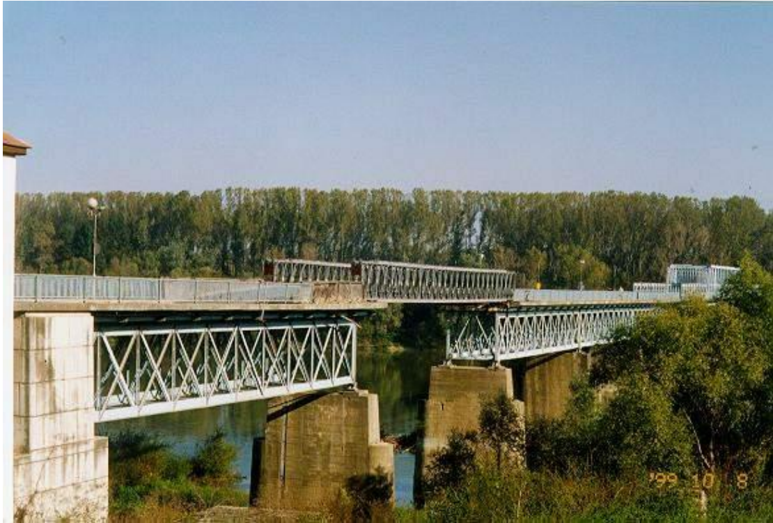
4. sz. kép M&J hídszerkezet helyettesíti a leszakadt hídszakaszt Szerbiában 7
