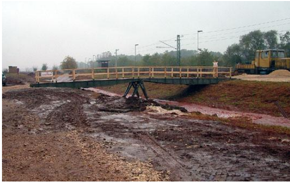
5. sz. kép „Rögtönzött” híd Kolontáron 9
