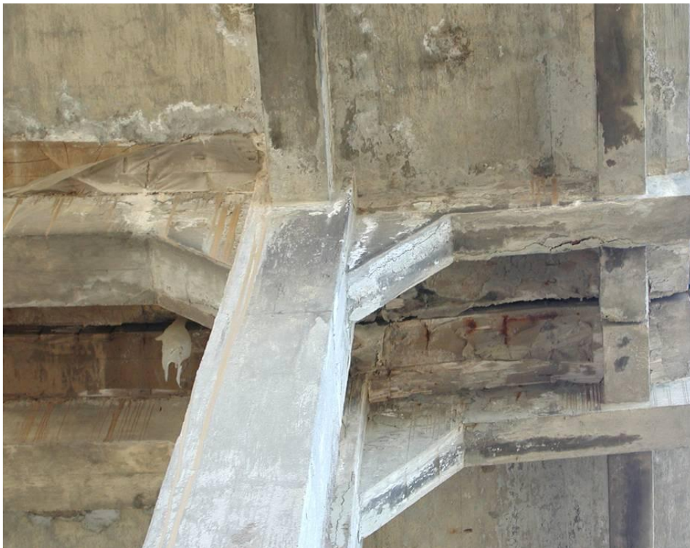
3. sz. kép A sózás negatív hatása a hídszerkezetre 5
