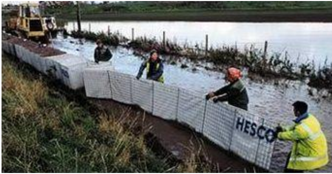
Az építőelemek telepítése 19
