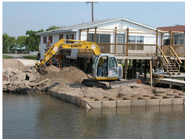
Járófelület létesítése tóban 14
