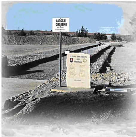
Útfelület kialakítása ideiglenes vízfolyásban 13
