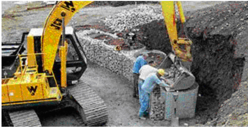
„Költséghatékony” fal építése 25
