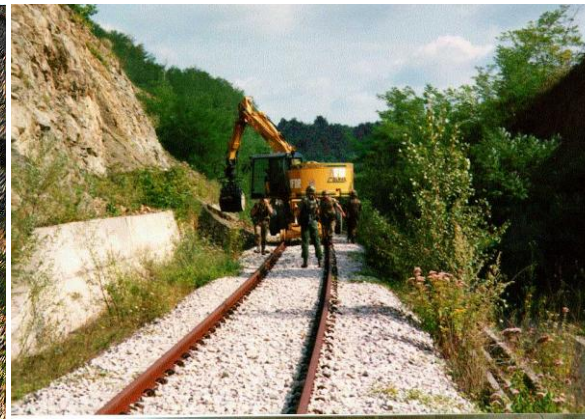
Vasútvonal védelme támfallal 12
