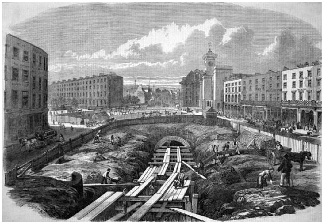
1. sz. kép A Metropolitan Railway, a világ első földalatti vasútjának építése 3
