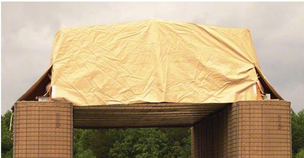
14. sz. kép A HESCO kistömegű óvóhely-tetőszerkezet 24
