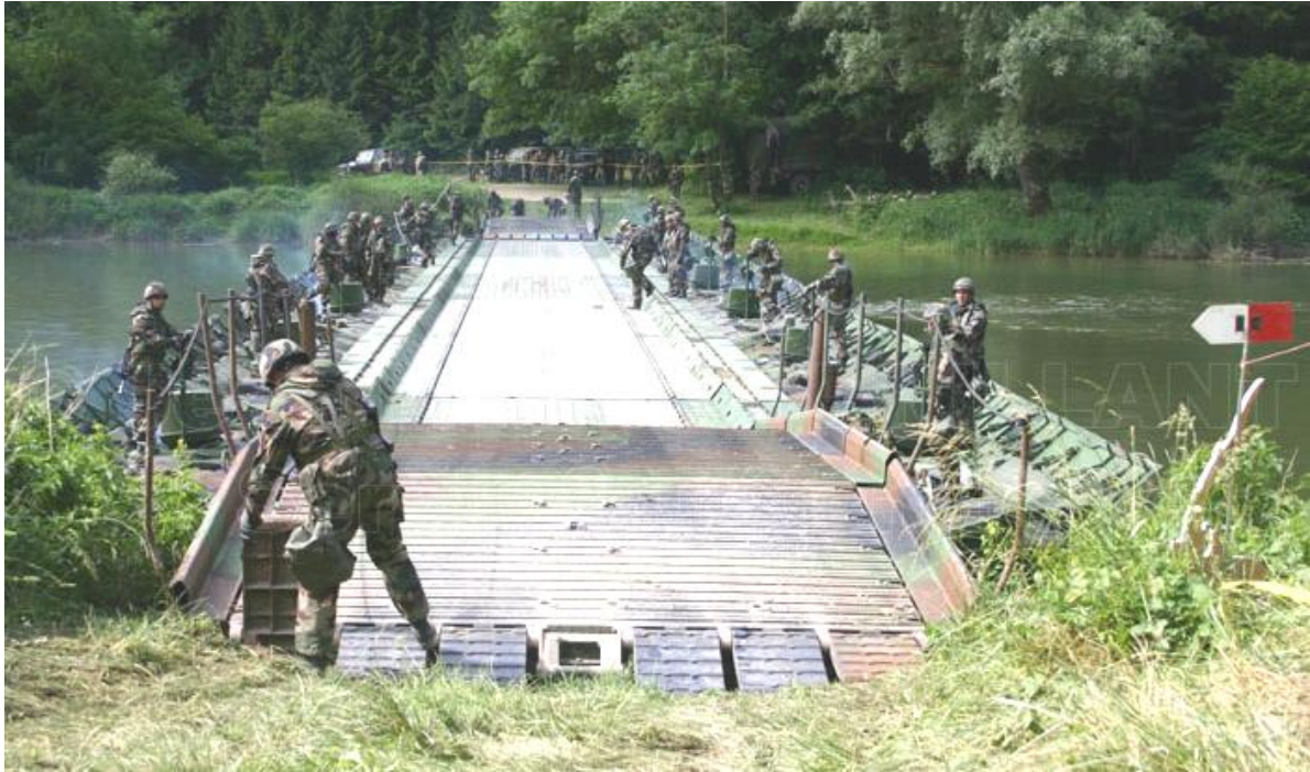
11. sz. kép A kész híd 22
