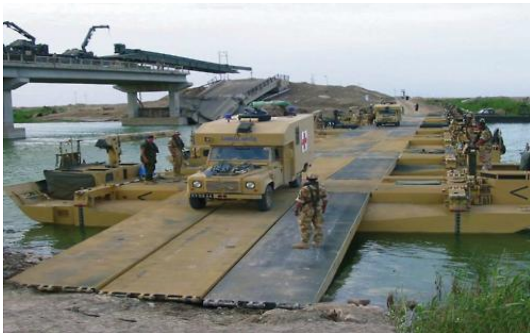
23. sz. kép M3 üzemelő híd 44
