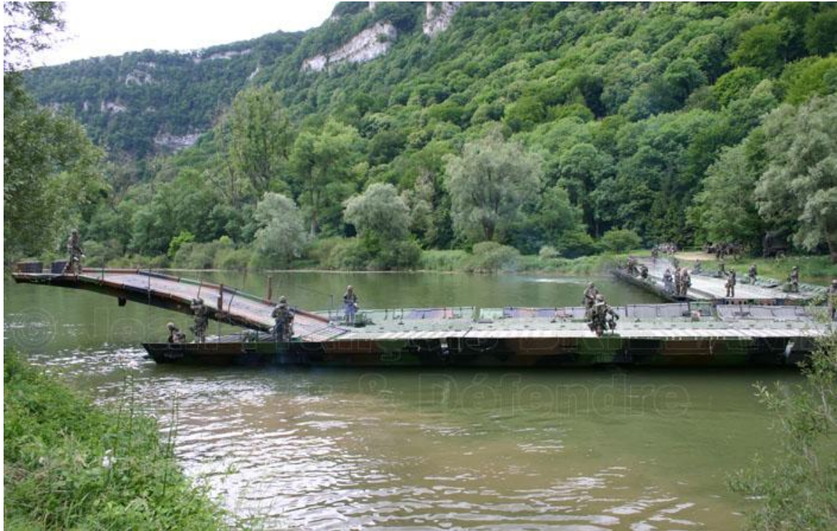
17. sz. kép Hídépítés „befordítással” 29
