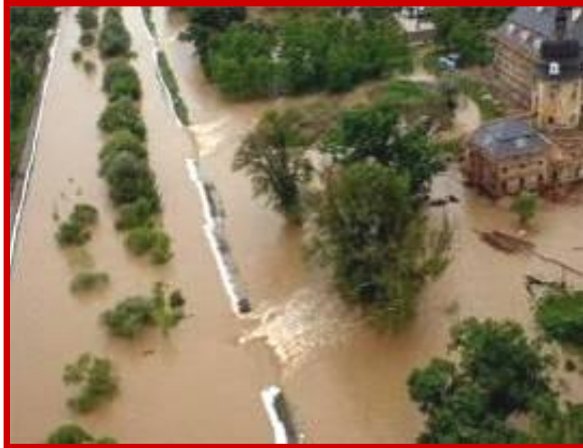
4. sz. ábra: Gátszakadás Edelényben: Forrás: 12
