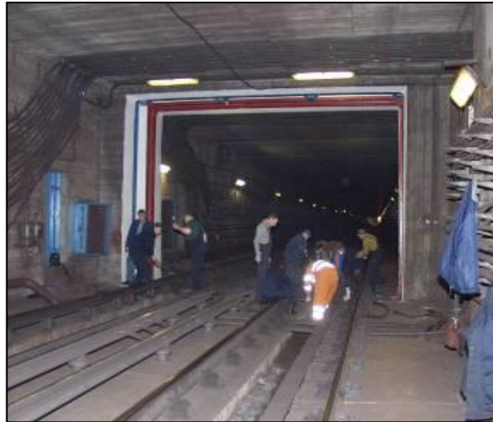
4. sz. kép: Vonali elzáró kapu bezárás előtti munkálatai 6
