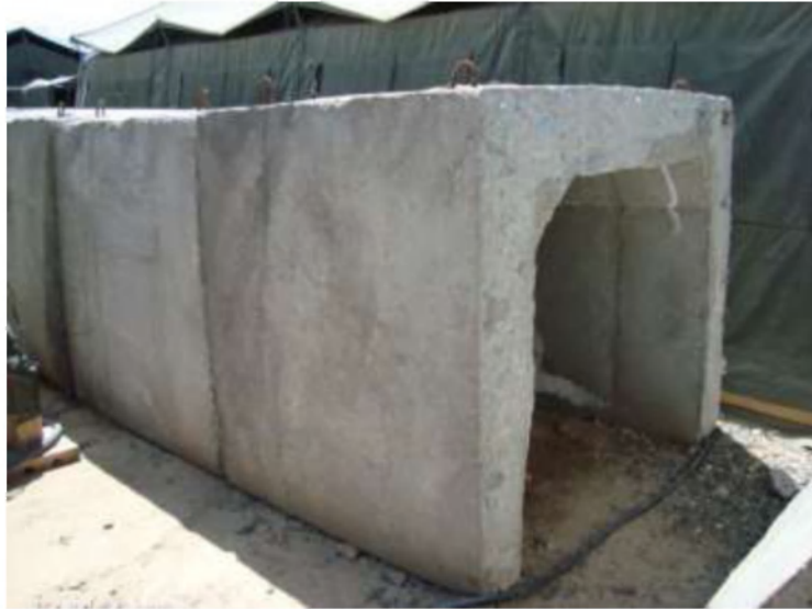
11. kép. Vasbeton alagút elemek
