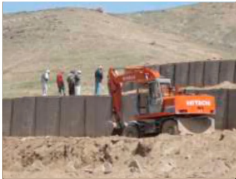
9.-10. kép. A fémhálós keretek földdel való megtöltése történhet gépi vagy kézi erővel
