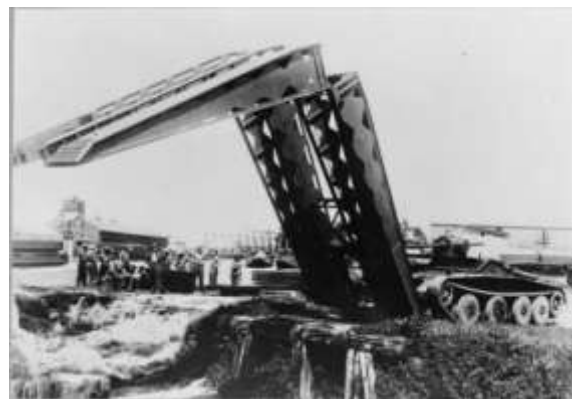
3. sz. kép Ollós hídszerkezet 8
