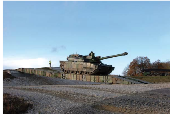
14. sz. kép Áthaladás a kész hídon 36
