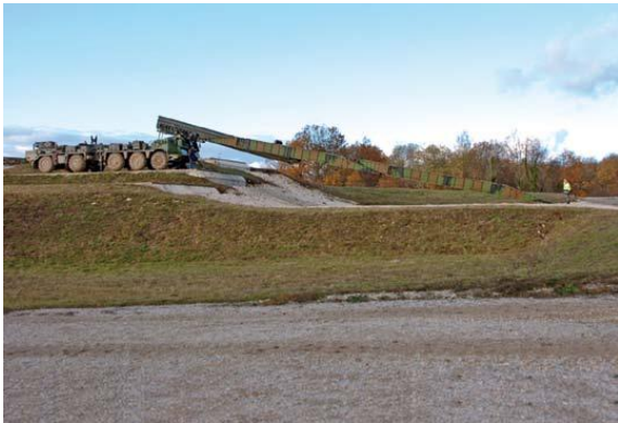
13. sz. kép A híd telepítése 36
