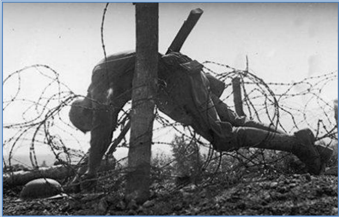
Nem robbanó műszaki zár – drótakadály 8
