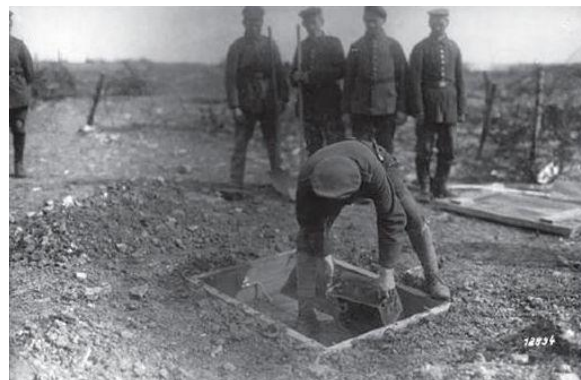
Kiképzés: a Flachmine–17 telepítése [22]
