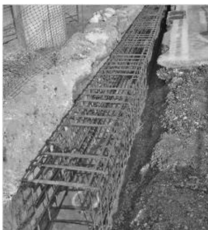
13. Kép: Kiépített rácsrendszer betonnal történő kiöntés előtt [1]
