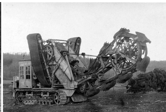
Német láncotlappal „rotoros” árokásó 92
