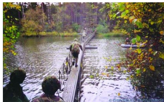
11. sz. kép Átkelés az úszó aljzatú hídon 23
