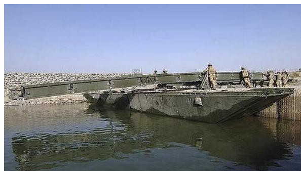
35. sz. kép A komp építése 62
