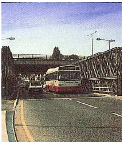
18. sz. kép Kétsávú híd 35
