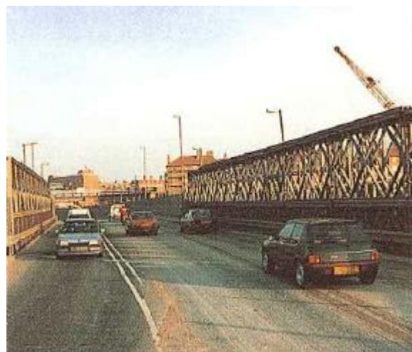
19. sz. kép Háromsávú híd 35
