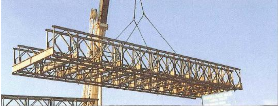
21. sz. kép A híd (híd rész) beemelése daruval 38
