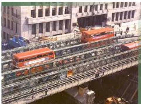
16. sz. kép A Mabey Szuper Bailey Híd valahol Londonban 34
