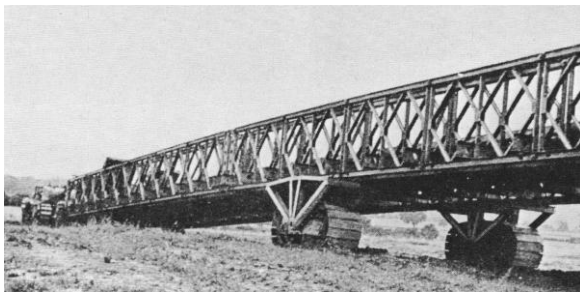
10. sz. kép „Mobil” Bailey híd 24
